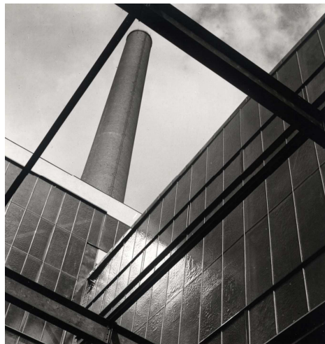
J. Funke, Elektrárna ESSO, 1932
