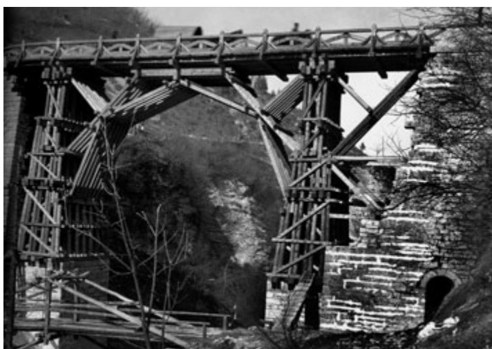
Při ústupu je nutné nepříteli ztížit postup, třeba stržením mostu. Poté se musí vybudovat nouzová lávka. Autor Jindřich Bišický.
