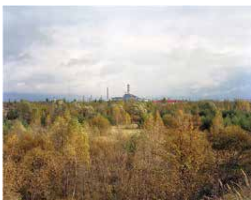
Pohled na elektrárnu Černobyl v roce 2004
