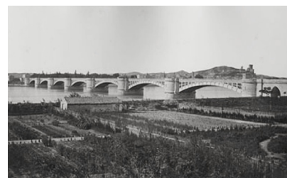
Édouard-Denis Baldus, Tarascon Viaduct , 1860
