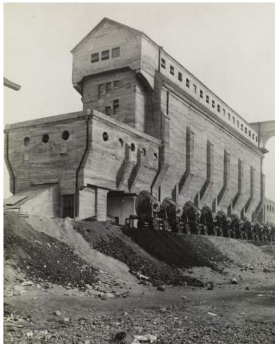
Albert Renger-Patzsch Míchací zařízení uhlí , 1929
